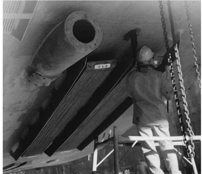
**Cuando sea necesario reparar la unidad DuraCooler® sobre el terreno, recomendamos realizar soldaduras mediante el siguiente procedimiento:**
