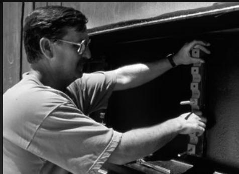
Las barras roscadas 3/8 pulgadas cuelgan temporalmente los componentes del enfriador de la cubierta superior. Este método facilita el ajuste de las piezas del conjunto para su ubicación exacta antes de apretar y fijar los pares de apriete finales. Este proceso de montaje hace que el manejo y colocación del sistema de enfriamiento sea mucho más fácil.
